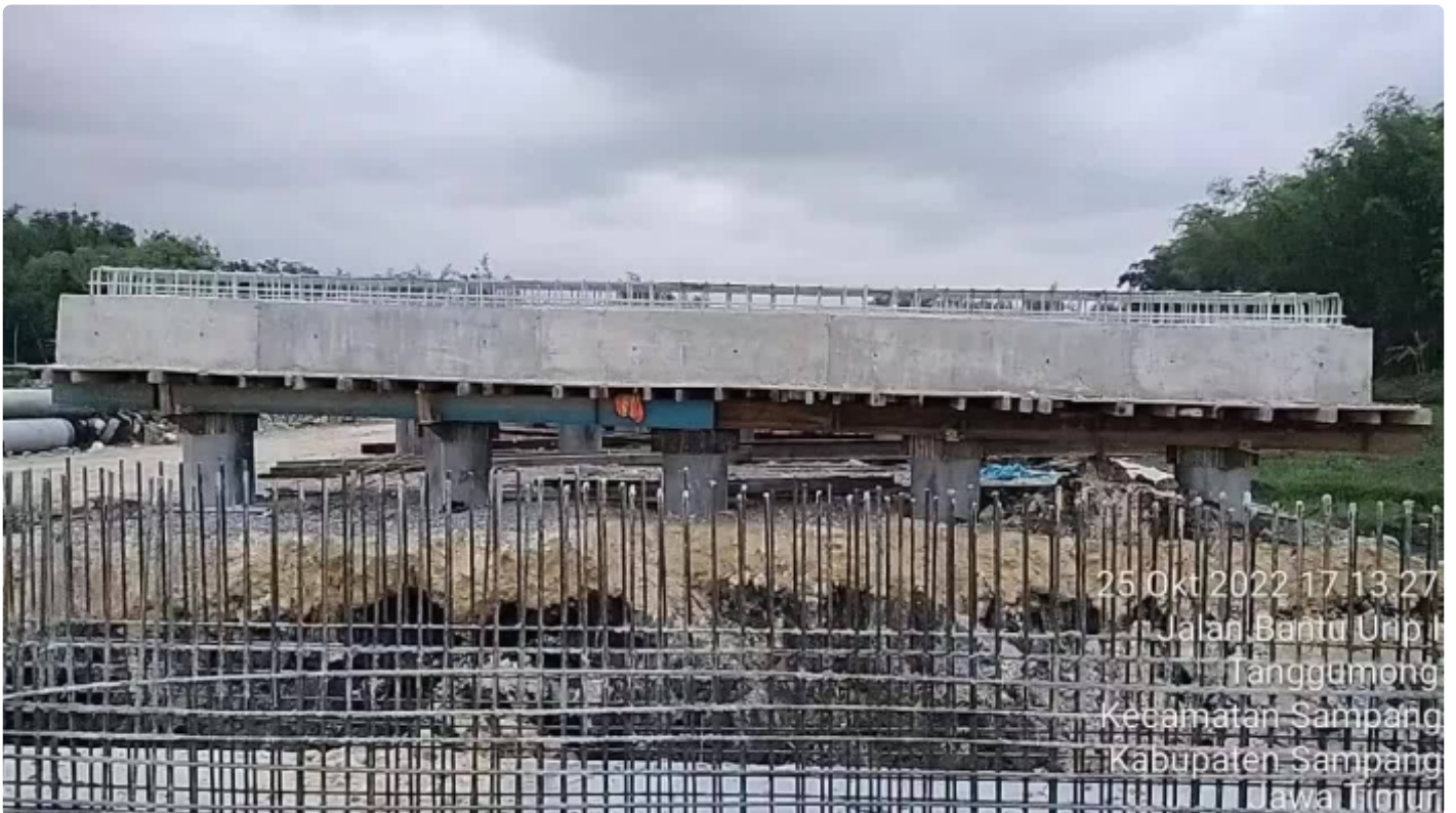
Lokasi Pembangunan JLS Sampang yang masih dikerjakan
